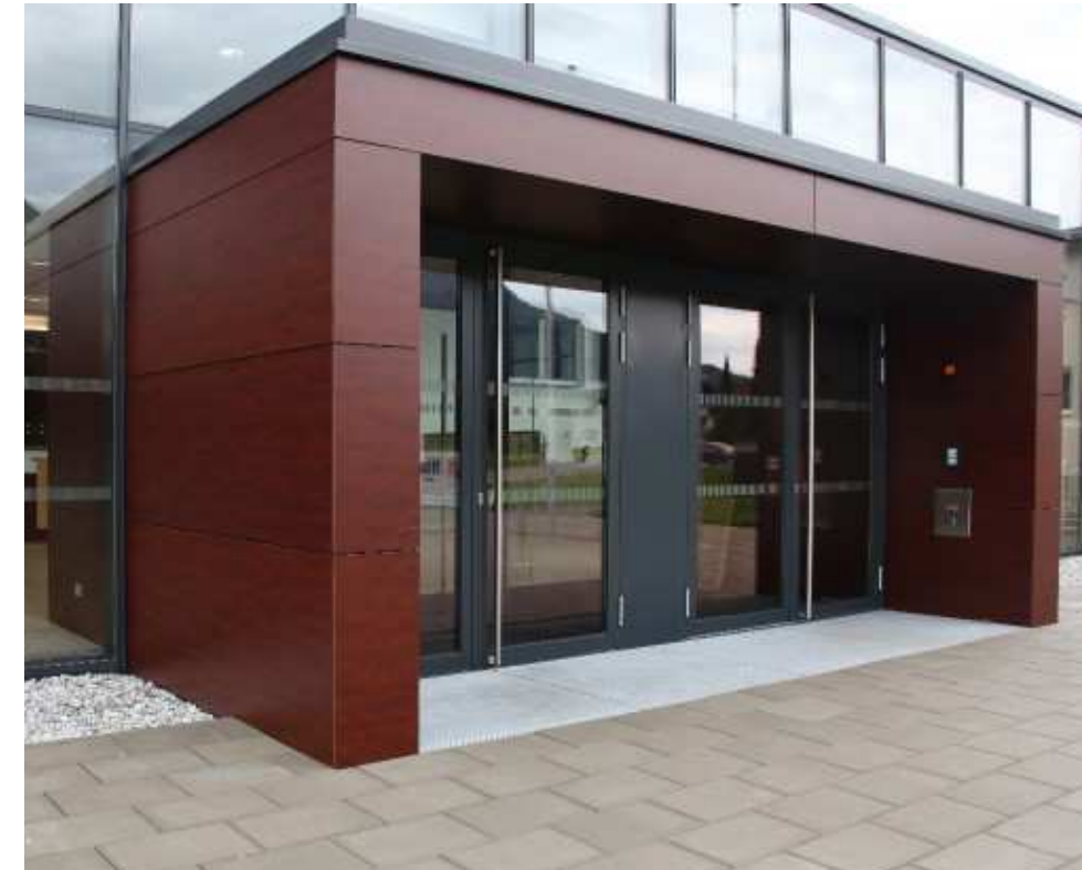
Obkladové desky z vysokotlakého laminátu vytváří výrazné akcenty vstupních částí objektu.
