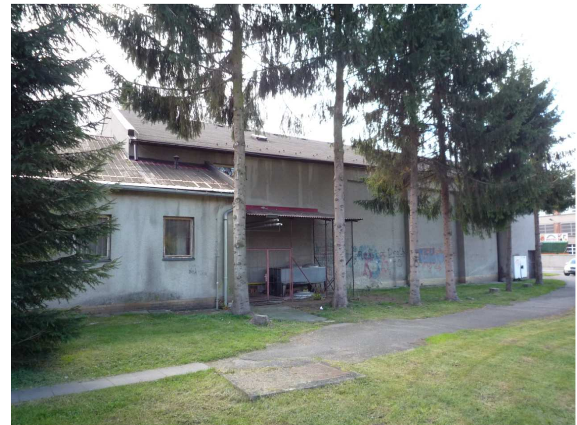
POHLED NA OBJEKT ZE SEVERNÍ STRANY
