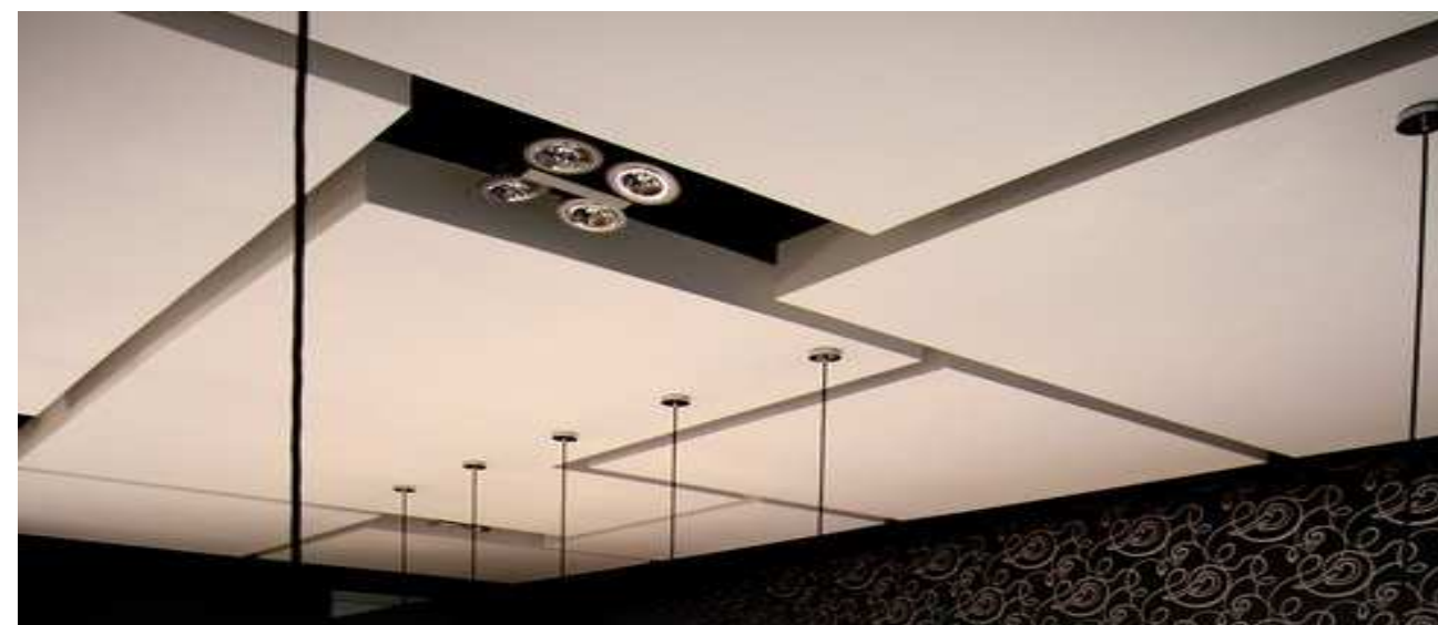
Kombinace pevných a plovoucích akustických podhledů – pevné SDK podhledy a zavěšené akustické absorpční panely z melaminové nenaplněné pěny (povrchová úprava akustickou textilií). Zavěšená akustické panely zajistí jednak zvukový útlum prostoru a umožní případné doplnění světelné techniky v závislosti na potřebách budoucího provozu. Současně vytváří zavěšené panely nezaměnitelný výtvarný efekt.
